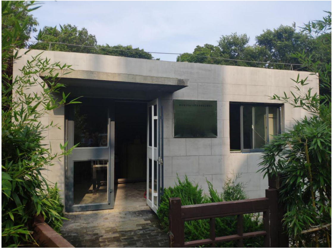
图 74 刘公岛污水处理站
